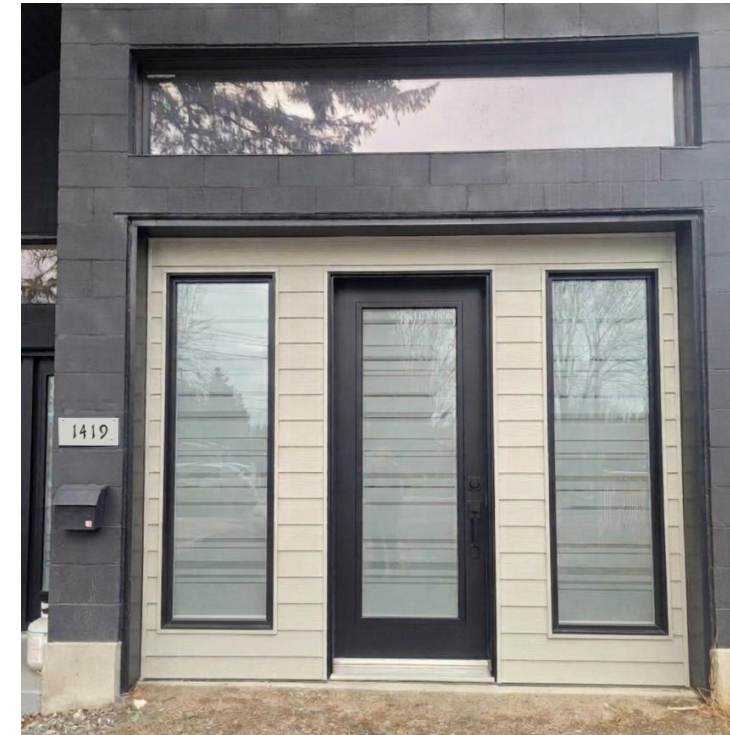
remplacement de la porte de garage par 2 fenêtres et 1 porte (généré par IA)
